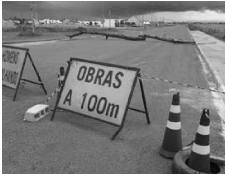
Grandes obras ficarão em andamento
